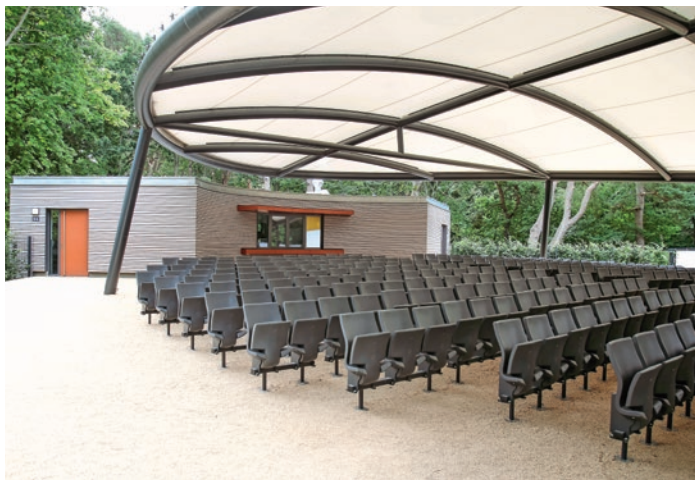
Zuschauerbereich mit Überdachung aus textiler Membran und Funktionsgebäude
